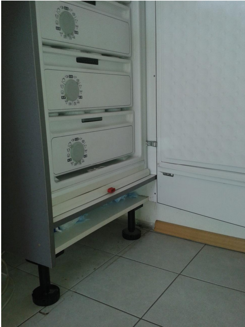
Bild 5: Nebenbelüftung wurde mit Lappen zugestopft
